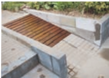
個人宅に車椅子移動用木製スロープ工事
