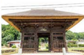
善光寺楼門。平成5年度から7年度にかけて解体修理が行われました
